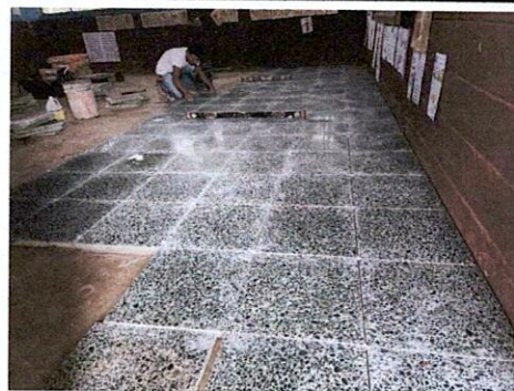
Foto 6: Mantenimiento de piso en aulas
