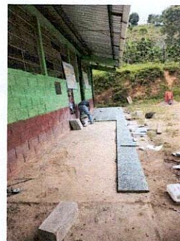
Foto 2: Mantenimiento piso corredor
