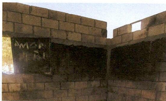
Foto 5: Reparación y Mejorameinto de paredes de cocina
