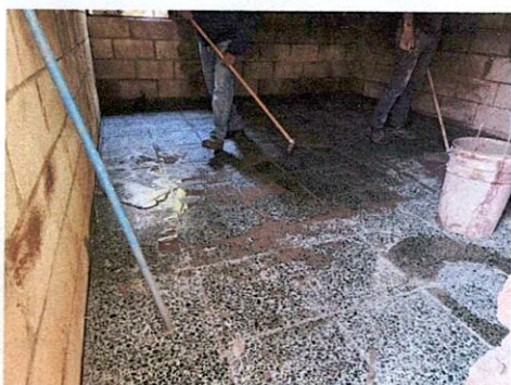
Foto 3: Reparacion y mejoramiento piso cocina
